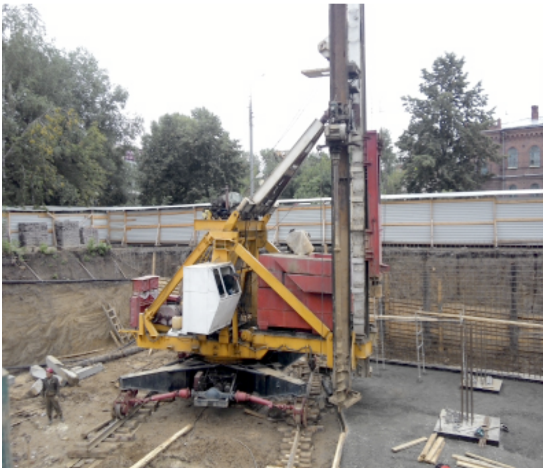
Рис.1. Общий вид сваевдавливашей установки (СВУ) на строительной площадке в г. Томске (2015 г.)
