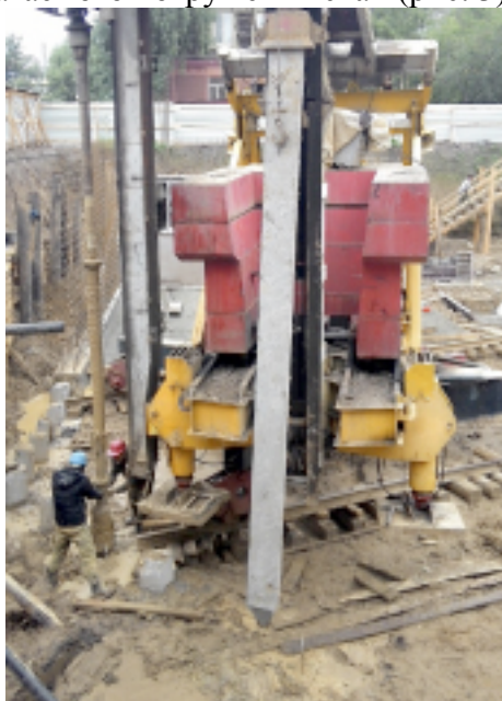
Рис. 3. Предварительное бурение лидерной скважины перед погружением готовой сваи на строительной площадке в г. Томске (2015 г.)
