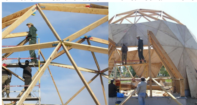
Рис. 3. Процесс возведения каркаса купольного здания на основе метода геодезической сферы
