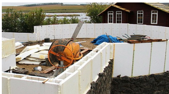
Рис. 6. Процесс устройства купольной конструкции на основе метода несъемной опалубки.
