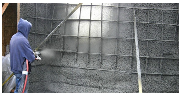
Рис. 5. Нанесение основного материала на купол
